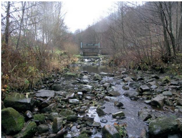
Abbildung 2-6: Zu geringe Wassertiefe behindert die Durchgängigkeit
